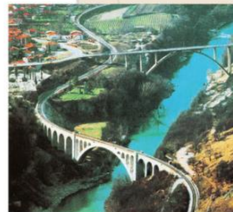
V ospredju je kamnit železniški most v Solkanu, zgrajen leta 1906, v ozadju pa cestni most iz leta 1985.
