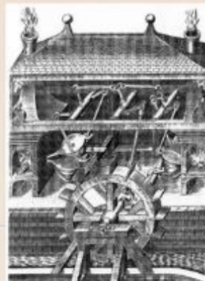
Vodno kolo poganja mehove - fužina v 16. stoletju. Z močnejšim razpihovanjem ognja v pečeh so dosegli višje temperature, s tem pa boljše in hitreje topljenje železove rude.
