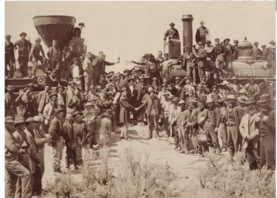
Američani so železnico preko celine istočasno gradili z vzhoda in zahoda, dokler se nista obe skupini graditeljev leta 1869 srečali v državi Utah, s čimer je bila železnica dograjena.
