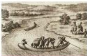
Pred gradnjo železnice je imel izjemen pomen račni promet. Brodarstvo po Savi (rišba je iz Valvasorjeve Slave vojvodine Kranjske) je zamrlo leta 1862 z gradnjo železniške proge od Zidanega Mostu do Siska.
